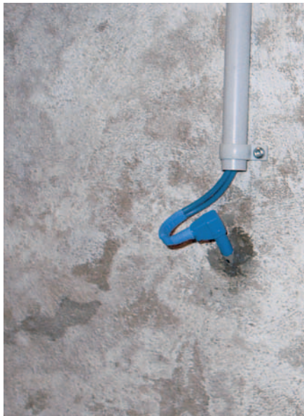
Die Titan-Elektrode des Systems Drymat®.
